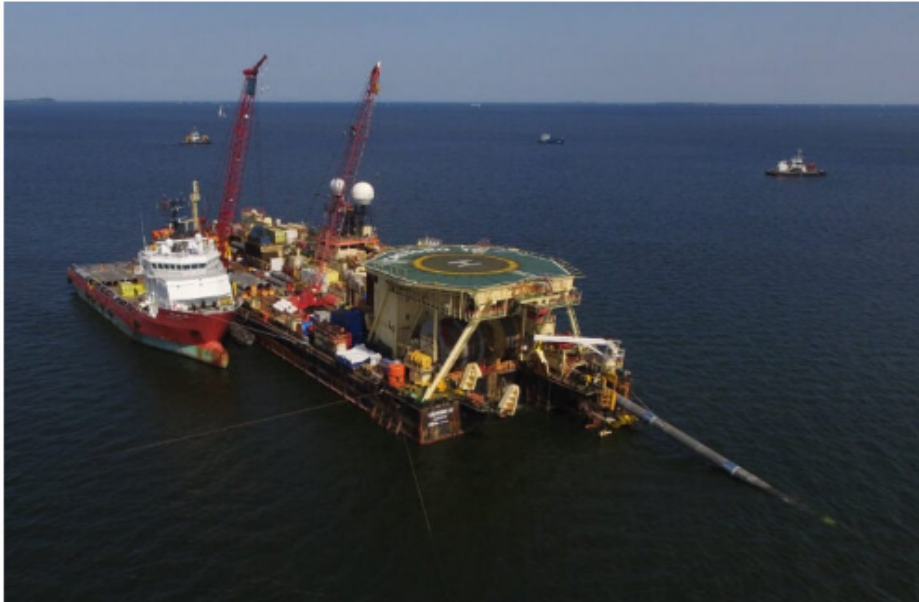
Das Verlegeschiff Castoro 10 verlegt am 16. August 2018 in der Nähe von Lubmin betonummantelte Rohre für die Nord Stream 2-Gaspipeline auf dem Meeresgrund der Ostsee. Foto: Sean Gallup/Getty Images
